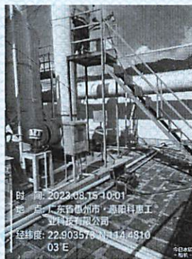
图 11: DA003 酸性废气排放口
