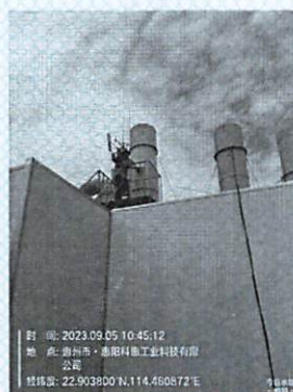
图 21: DA004 有机废气排放口
