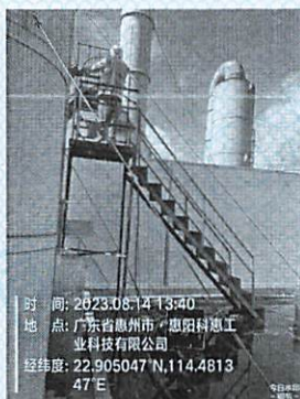
图 6: DA002 酸性废气排放口
