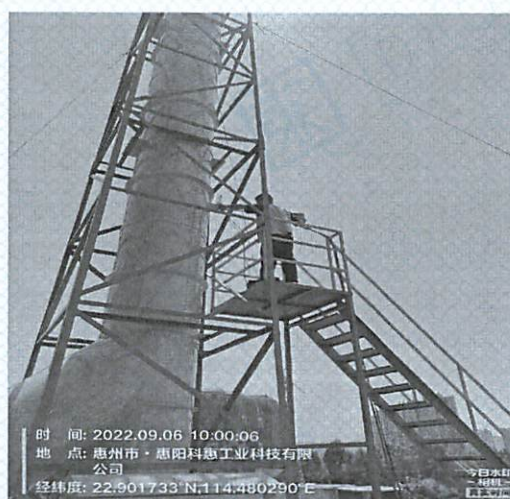
图 10: DA008 酸性废气排放口
